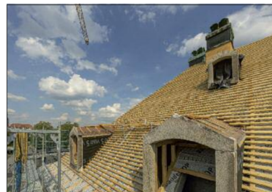
Das Dach des zum Teil denkmalgeschützten Gebäudes wurde im Zuge der Umgestaltung für das Archiv der Avantgarden authentisch wiederhergestellt. Für die Holzkonstruktion der Dachfläche wurden über 70 Kubikmeter Brettschichtholz und bis zu 11 Meter lange Sparren verarbeitet.
