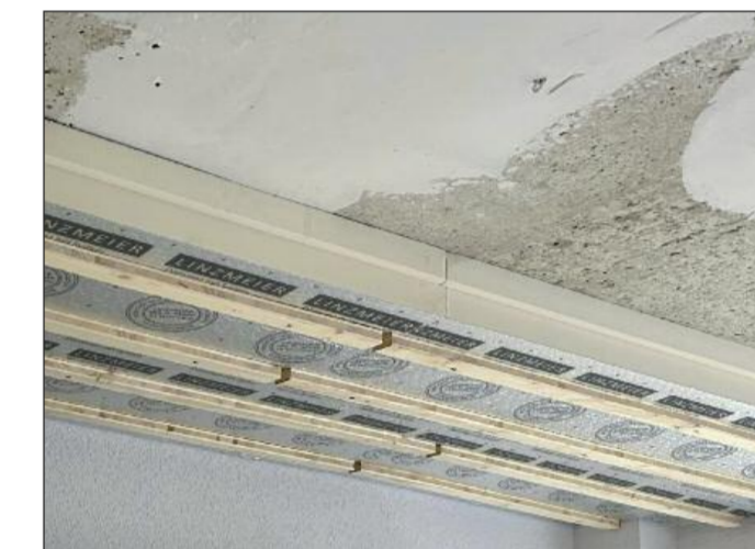
Neben der kurzen Montagezeit bietet die neue Innendämmung LINITHERM PAL UK eine minimale Aufbauhöhe dank hoher Dämmeffizienz ( \lambda 0,023). Die raumseitige Beplankung ist frei wählbar, die elektrische Ausstattung (LED-Spots, Steckdosen etc.) lässt sich schnell und sicher einbauen oder nachrüsten.
