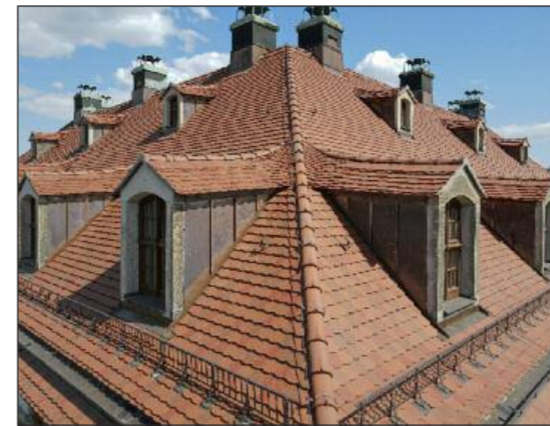
Die 1.061 Quadratmeter große Dachfläche des Dresdner Blockhauses erhielt eine Eindeckung mit „Profil Sächsische Biber“ mit profilierter Oberfläche in einem Sonderformat, die von Creaton in vier fein nuancierten Naturrot- Kupferrot-Farbtönen produziert wurden.
