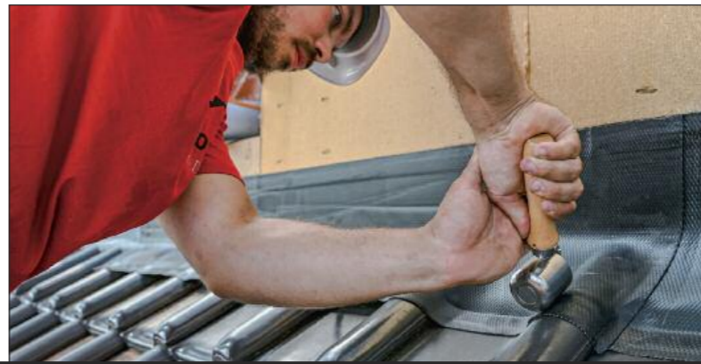
Ubbink ersetzt Bleianschlüsse am Steildach
