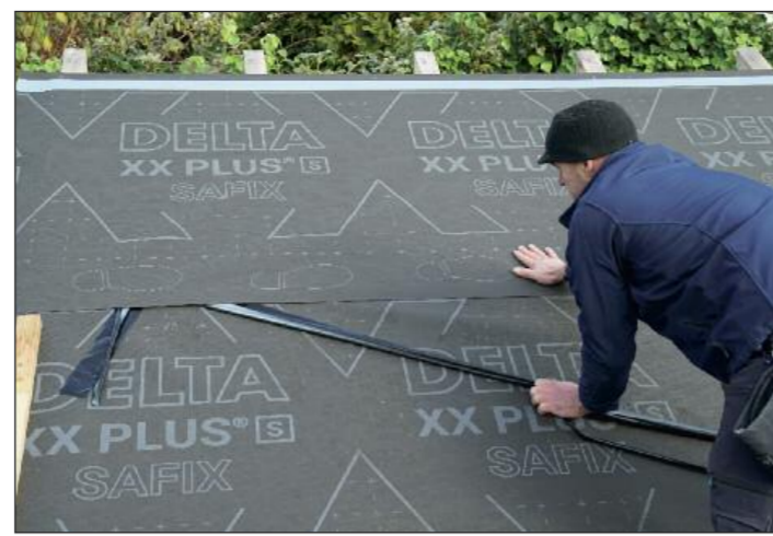
Die Klebestreifen ermöglichen eine langfristig sichere und dichte Verbindung ohne Nacharbeiten.
