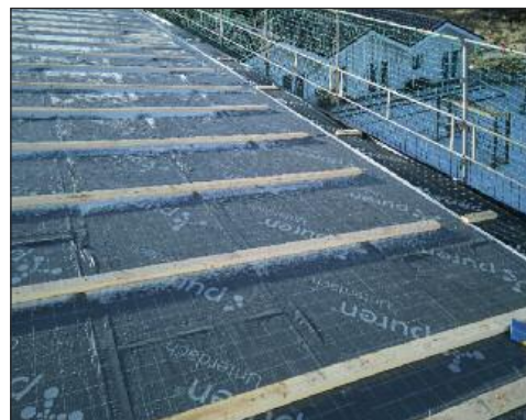
Über die notwendige Konterlattung werden die PU-Dämmstoffplatten mittels passender Systemschrauben im Untergrund fixiert. | Foto: puren
